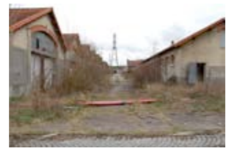
La Caserne Bossut, Cergy-Pontoise
